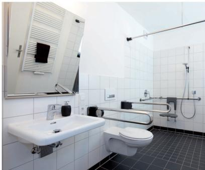
Barrierefreies Bad: gekippter Spiegel, stufenlose Dusche sowie WC mit Haltegriffen
