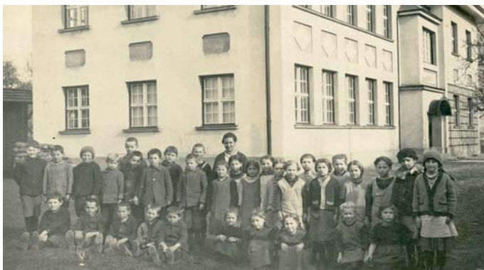
Schulklasse vom dem 1911 erbauten Schulhaus in der Schulstrasse
